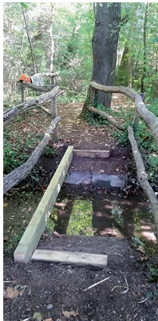
Reconstruction du pont sur l'étang des Ecrevisses à Pregny-Chambésy
