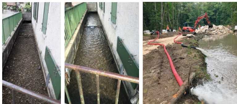
Le Brassu avant/après l'intervention de l'ORPC Valavran | 1 & 2 septembre 2019
