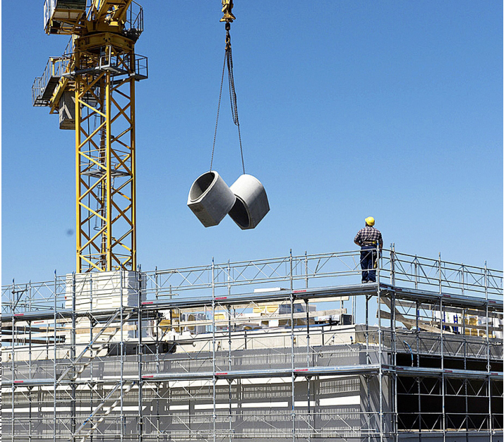
Vue sur le chantier durant la construction de l'école.
