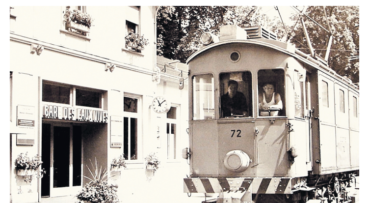
Un vieux tram devant l'ancienne gare des Eaux-Vives. DR
