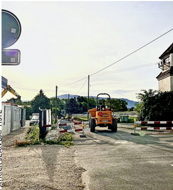
Des travailleurs à l'œuvre au chemin des Gravannes.
