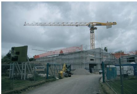
une construction en béton isolant, une charpente en bois, un toit végétalisé, ainsi qu'une production d'énergie d'origine géothermique. A la fin 2011, 6'000 m<sup>3</sup> de terre ont été excavés, 1'000 m<sup>3</sup> de béton ont été mis en œuvre, 103 tonnes d'acier ont été utilisées et 1'100 m<sup>2</sup> de murs ont été coffrés, avec un effectif moyen sur le chantier de 12 à 16 personnes. Grâce à un appareil de photos situé
