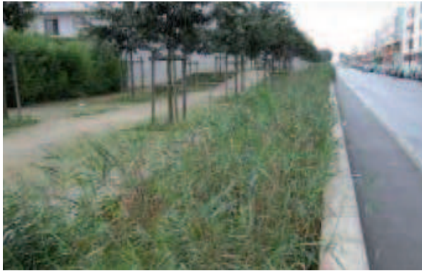
Référence : Noue végétale en bordure de trottoir - France
